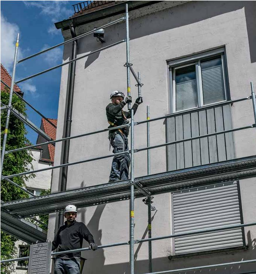
**Das Geländer für die nächste Gerüstlage wird mit dem Easy Rahmen von der unteren Ebene aus montiert. Dadurch ist der Gerüstbauer bereits bei Betreten der nächsten Ebene gesichert. Weitere Details, wie die integrierte Belagsicherung, tragen zur sicheren Anwendung bei.**
