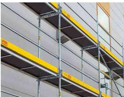
Bei den PERI UP Easy Belägen ist die Abhebesicherung integriert: Die Bügel untergreifen den Horizontalriegel und sichern den Belag.
