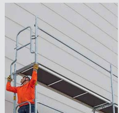
Das vorlaufende Stirngeländer wird als permanenter Stirnseitenschutz schon von der unteren Gerüstlage aus in der nächst höheren Ebene montiert.
