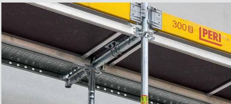
Sowohl die Kombibeläge mit 66 cm Breite als auch die 33 cm breiten Stahlbeläge sind mit der integrierten Abhebesicherung ausgeführt. Alle Beläge decken immer die gesamte Systembreite ab; es gibt keine Spalten zwischen den Belägen.
