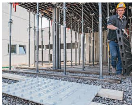
3. Bereitlegen der neuen Schalhaut
