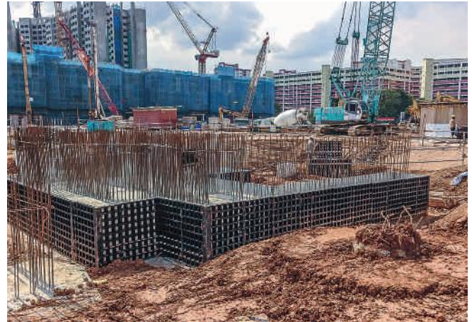
Aufwand für Reinigung und Nacharbeiten reduziert
