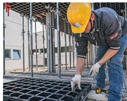
4. Festschrauben der neuen Schalhaut
