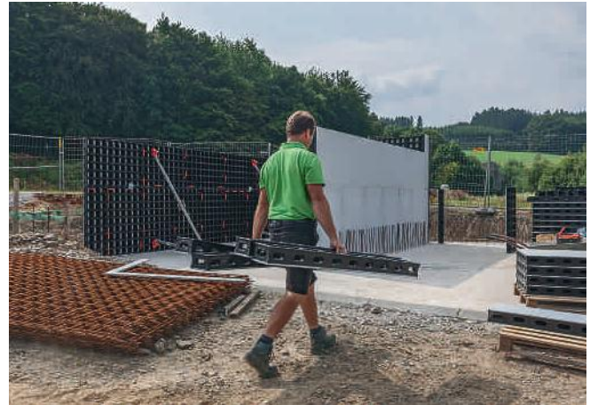
„Schalungs-Neulinge“ aus dem Garten- und Landschaftsbau nutzen DUO beim Schalen von Schüttgutboxen
