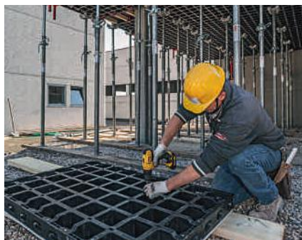
1. Lösen der Schrauben
