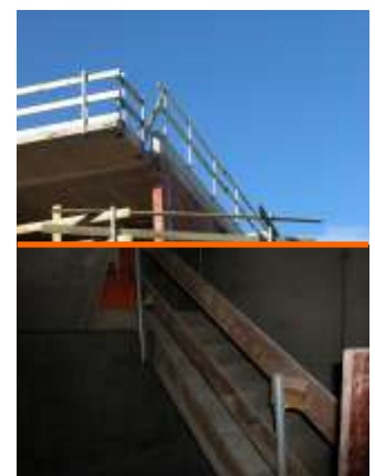
Winkeladapter kann seitlich in Treppenwangen o. Betonstirne eingeschraubt werden ...
