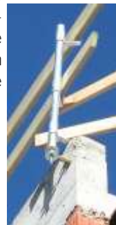
Winkeladapter kann seitlich in Treppenwangen o. Betonstirne eingeschraubt werden ...
