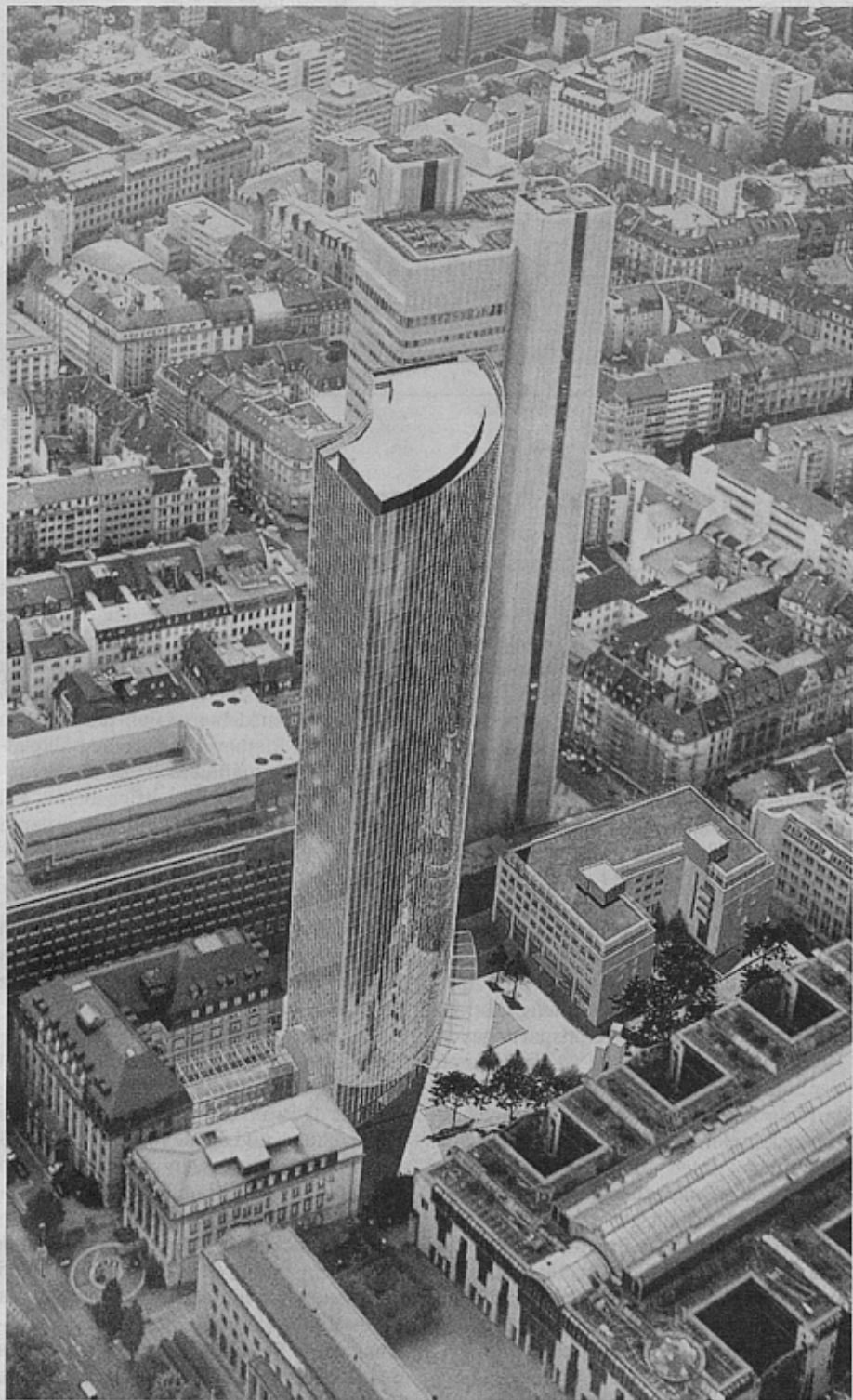
Beim Bau des 153 m hohen „Skyper“-Hochhauses setzt die Baufirma Müller-Altwater auf das Geländerhaltersystem Kerscher. Foto: Kerscher
