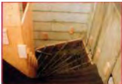
Der Fixophon-Belag wird auf das Wellengitter aufgelegt und passend zugeschnitten. Die seitliche Befestigung erfolgt mit Pappstiften auf den Holmen und in den Flächen mit Bindedraht.
