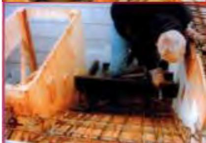
Die ausziehbaren Treppenstufen werden mit 65er Nägeln an den Stufenlaschen befestigt.
