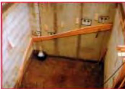
Schlüsselschrauben 8 x 80 mm an der Wand befestigen
