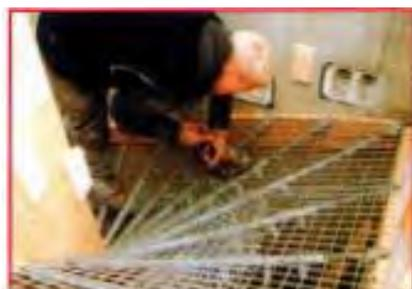
Die flexiblen Wellengitter werden auf die Teleskopstäbe gelegt und mit Bindedraht fixiert.
