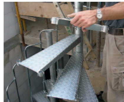
Stufen werden auf die Stufenhalter aufgesteckt
