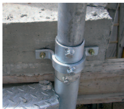
Rohrschellenbefestigung des Spindelrohrs ohne Distanzhalter
