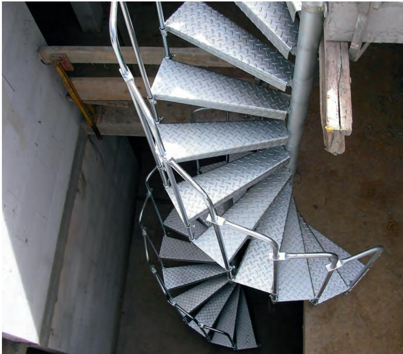
2 Geschoß-Bautreppen fertig eingebaut von oben
