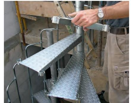
Stufen werden auf die Stufenhalter aufgesteckt
