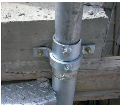
Rohrschellenbefestigung des Spindelrohrs ohne Distanzhalter
