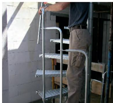
Geländerstäbe einfädeln und in Stufe stecken
