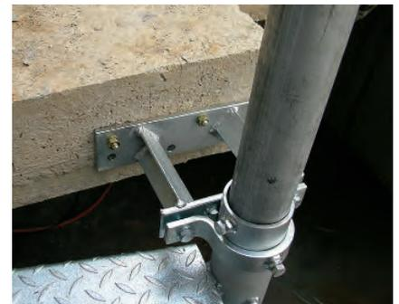
Spindelrohr mit Distanzhalter an der Deckenkante
