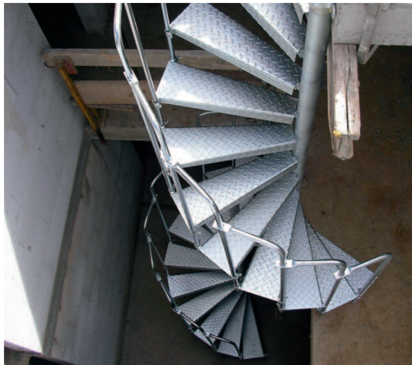
2 Geschoß Bautreppen fertig eingebaut von oben
