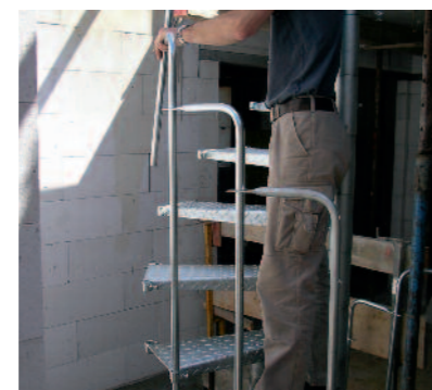
Geländerstäbe einfädeln und in Stufe stecken
