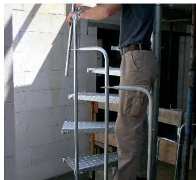
Geländerstäbe einfädeln und in Stufe stecken
