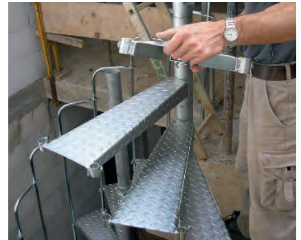
Stufen werden auf die Stufenhalter aufgesteckt
