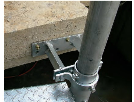
Spindelrohr mit Distanzhalter an der Deckenkante
