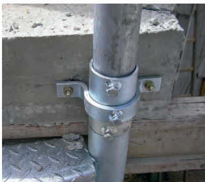
Rohrschellenbefestigung des Spindelrohrs ohne Distanzhalter
