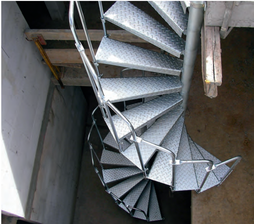
2 Geschoß-Bautreppen fertig eingebaut von oben
