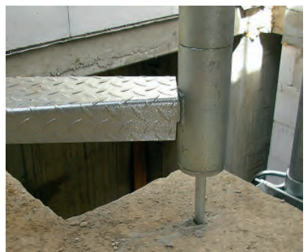
Fußteil mit Antrittstufe, 13 cm Bodenabstand
