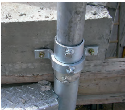
Rohrschellenbefestigung des Spindelrohrs ohne Distanzhalter
