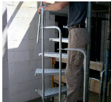
Geländerstäbe einfädeln und in Stufe stecken
