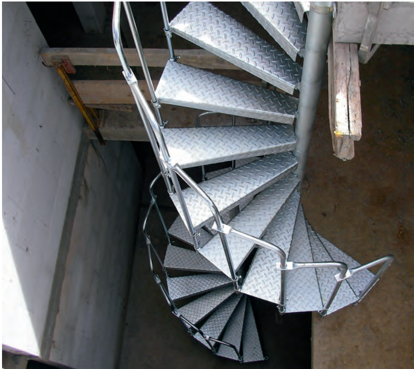
2 Geschoß-Bautreppen fertig eingebaut von oben
