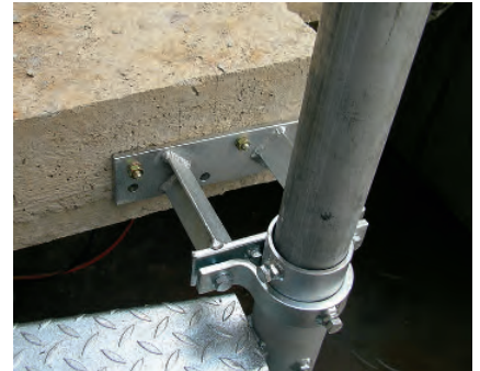
Spindelrohr mit Distanzhalter an der Deckenkante
