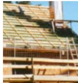
Die Konsole kann für Dachneigungen von 20 bis zu 60° eingesetzt werden und ist somit ein unentbehrliches Werkzeug für alle Dachdecker, Kaminbauer u.v.m.
