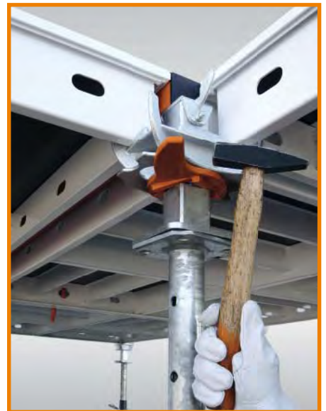
Testa cadente Tête de décintrement drop-head Cabezal caído Fallkopfsystem ПАДАЮЩАЯ ГОЛОВКА
