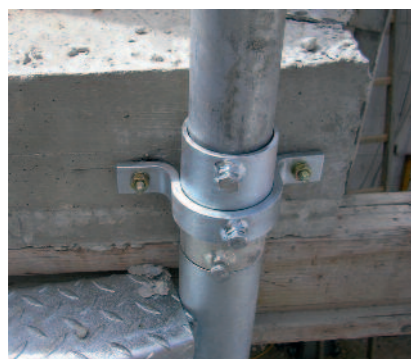
Rohrschellenbefestigung des Spindelrohrs ohne Distanzhalter
