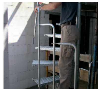
Geländerstäbe einfädeln und in Stufe stecken
